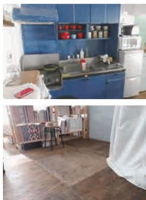
キッチンは全体をブルーに塗装。壁はクロスを張らずにペンキを塗り、コストを削減。床は合板を20枚ほど買って敷き詰めています。余った木材で廊下に棚を設置し材料を余すことなく工夫をしています。
