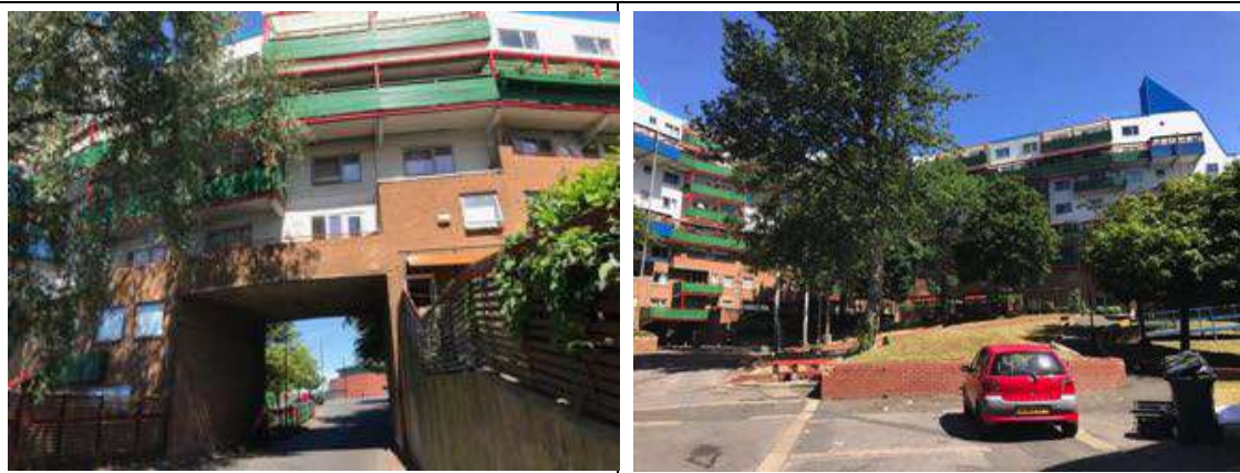
写真 4-21： バイカー・ウォール連続バルコニー（左）と三角のパラペット（右）
