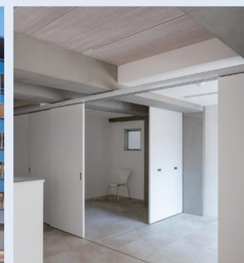
室内の間仕切りはすべて可動式。入居者自身が暮らしのニーズに合わせて空間を仕切ることができる。さらに、外壁に使用しているパネルも更新が可能。周辺や街の変化に合わせて柔軟に対応できるように建築されている。
