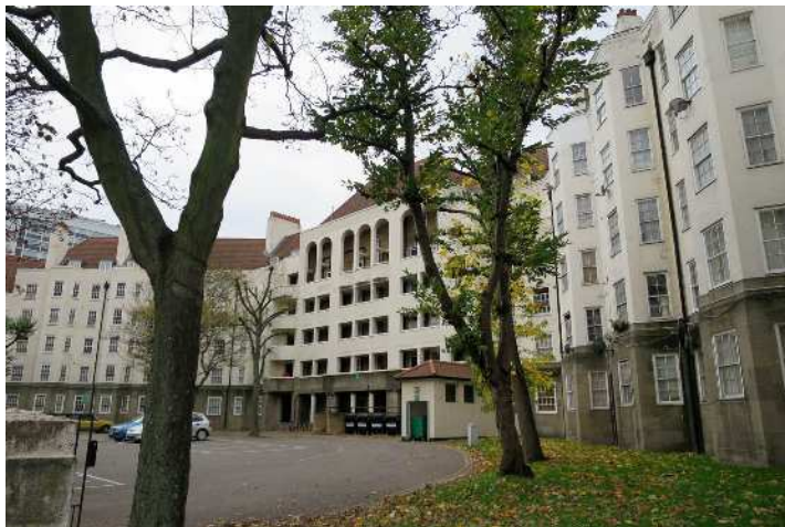
第一次大戦後のロンドンにおける住宅不足によりできる限り多くの住宅を供給する必要があったこと、また、建設された細長い敷地で、その当時公営住宅として一般的であった4-5階建ての中層の集合住宅が建築的に適していないと判断されたことにより、同時期にウィーンで建設されたカール・マルクス・ホフ団地(Karl Marx-Hof)を参考に鉄骨造による6-7階建ての住棟がデザインされたと言われている。 出典：http://thelostbyway.com のウェブサイト
