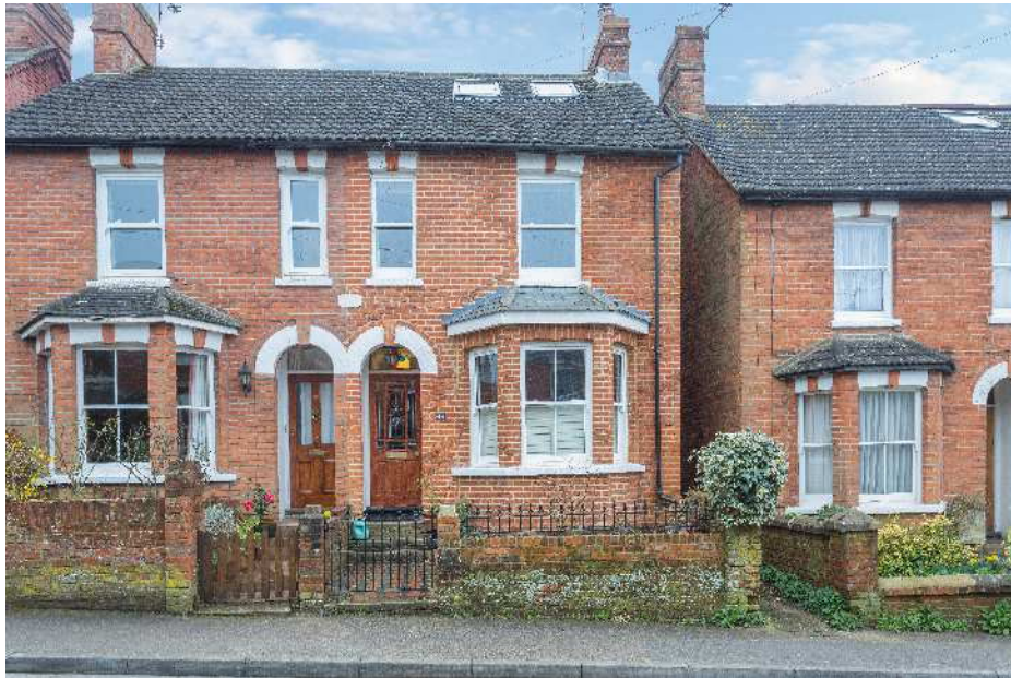
写真 3-7 レンガ壁の清掃と目地の補修後
