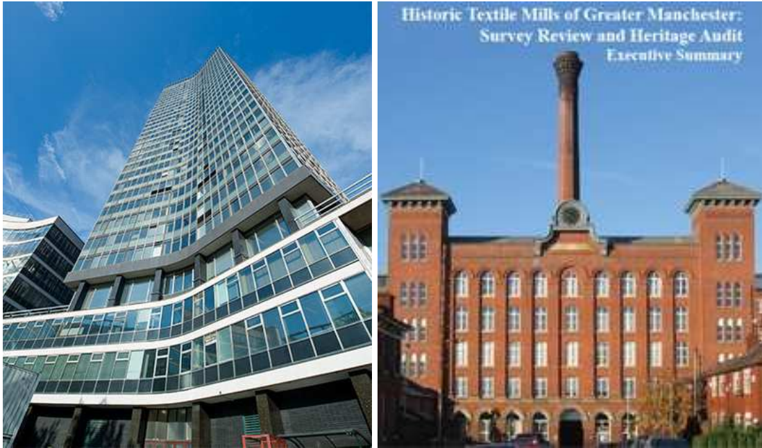
写真 4-4 ロンドンのミルバンク・タワー(左)とマンチェスターの製織所(右)のファサード
