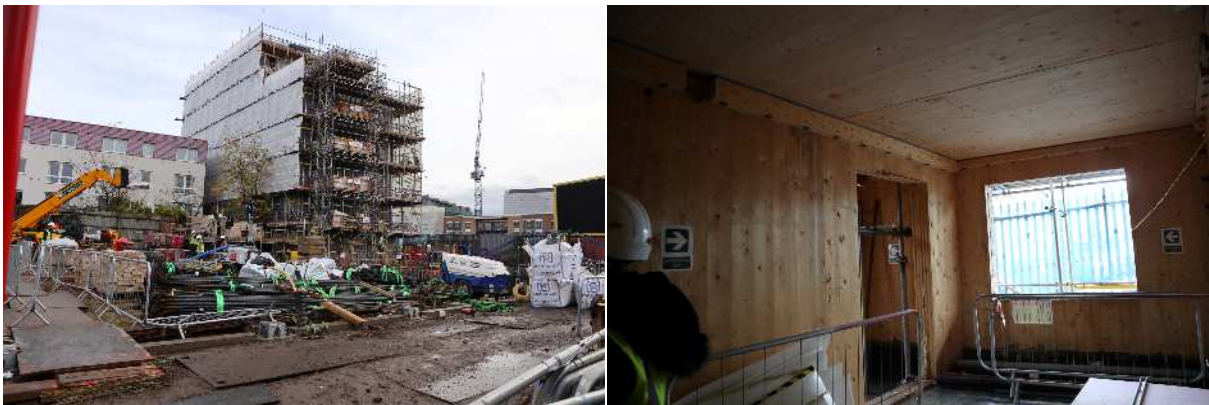
写真 3-3 ワッツ・グローブ、建築現場の様子－外観(左)及び CLT モジュール内部(右)
