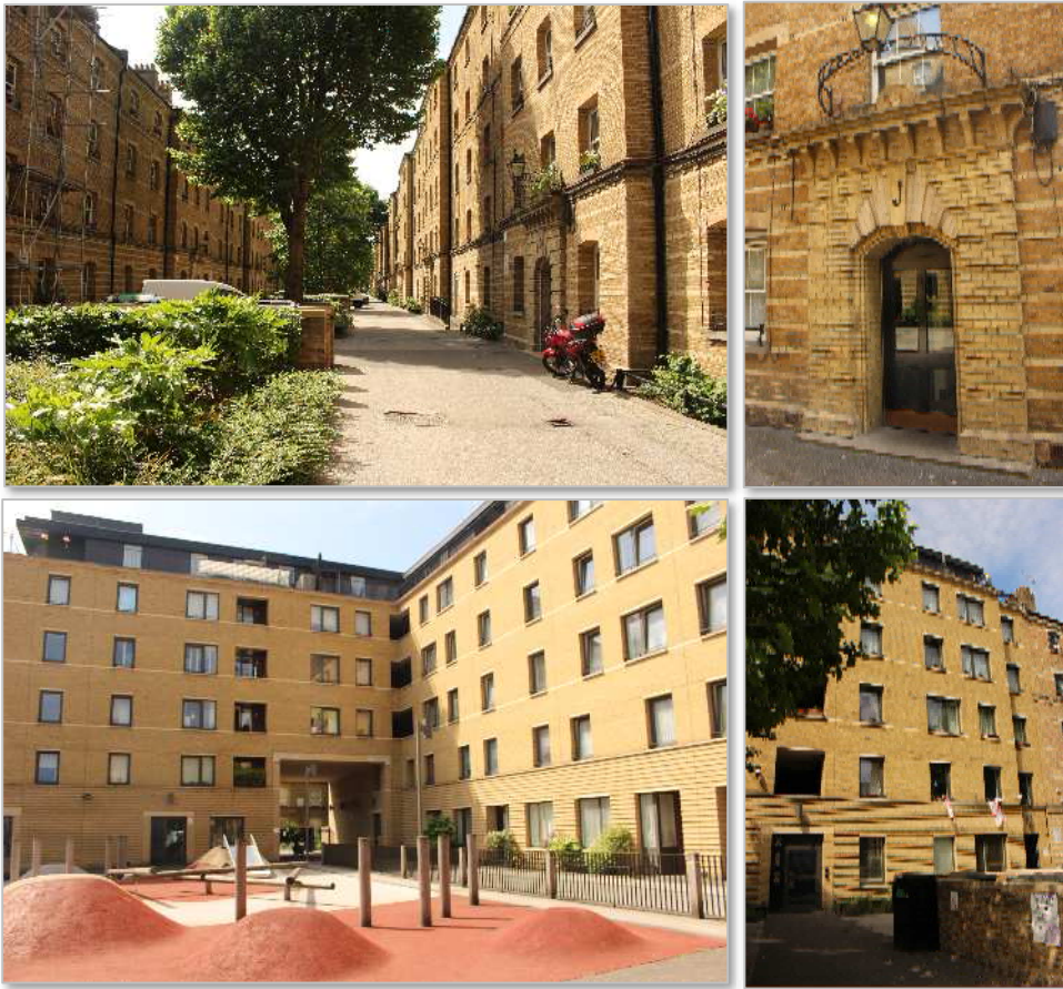
(左上)中央の中庭の様子。中央には植栽が整備されている。中央に植えられている木は、団地が建設されたときに植えられたものである。(右上)既存の住棟の入り口の様子。(左下)2011年に建設された住棟と同時に整備された子供の遊び場。(右下)既存棟と新築棟のつながる部分。スケール、窓のプロポーション、外壁の素材など、新築棟が既存棟を配慮してデザインしていることがわかる。 撮影：漆原、2021年6月
