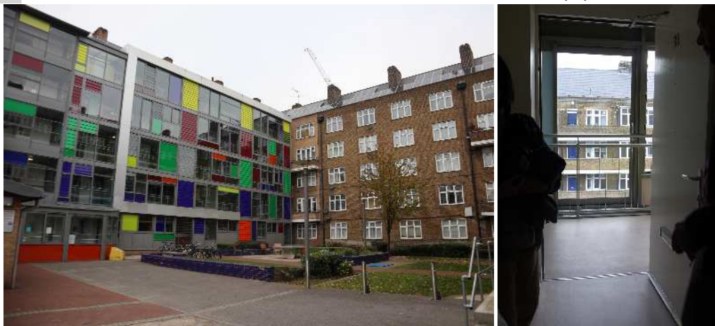
写真 3-11 室内の様子－車椅子に対応した住戸へのドア、幅が広げられ、床の段差がない(右)
