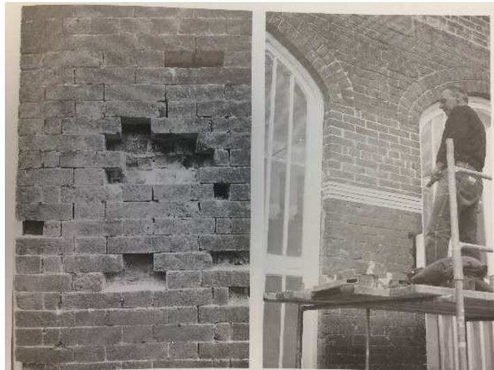
図 3-11 レンガの補修前と補修後の様子
