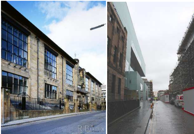
写真 3-1 グラスゴー美術学校、火事前の様子(左)及び 2017 年の第 1 回目の火事後の修復工事中の様子(右)
