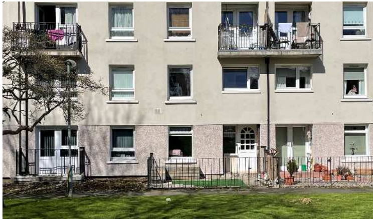
写真 6-5 グラスゴー市内にある公営住宅団地
